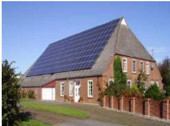
Erneuerbare Energien, Abwärmenutzung, Gebäudetechnik
